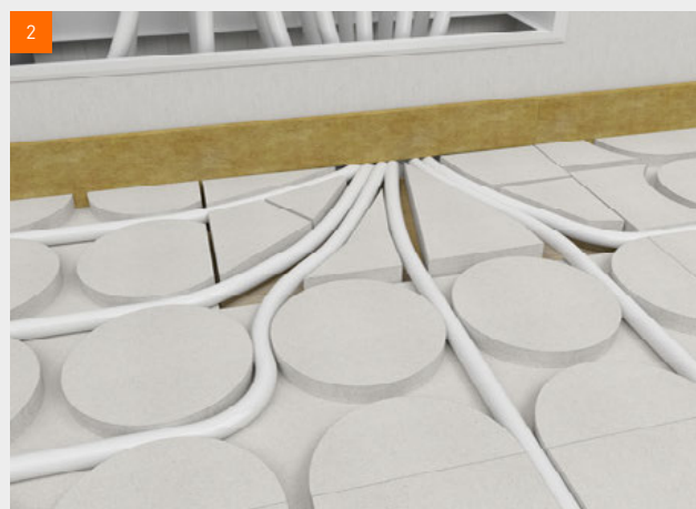
Opvullen met stukken uit fermacell® Therm 25™ of bijvoorbeeld honinggraatkorrels.
