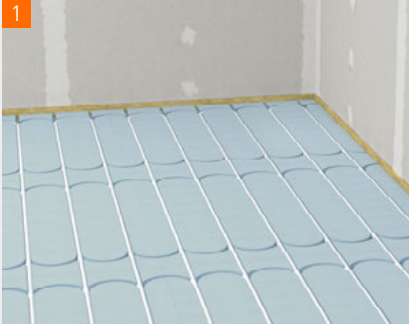
1 De aangebrachte vloerverwarmingsleidingen van 16 mm.
