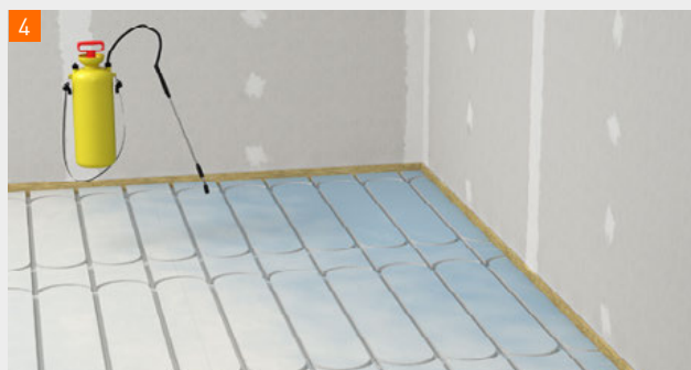
De fermacell® Therm25™ elementen met fermacell™ diepgrond gronderen.
