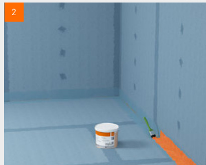
fermacell™ vloeibare folie in de hoeken aanbrengen
