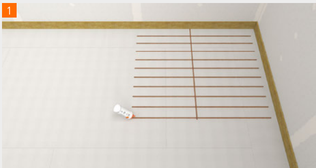
De lijmrillen aanbrengen.
