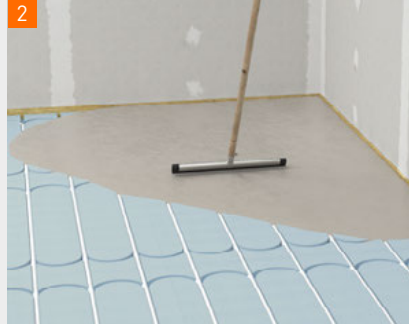
2 Over de fermacell® Therm25™ elementen fermacell™ gipslijm uitgieten.
