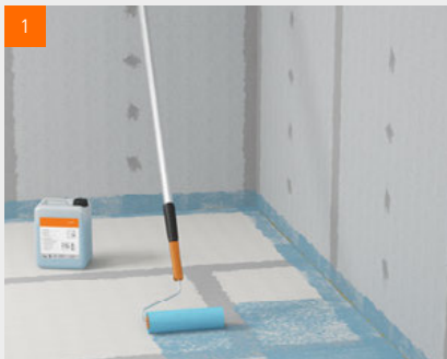
fermacell™ diepgrond op de daarvoor aangewezen zones met een rol aanbrengen
