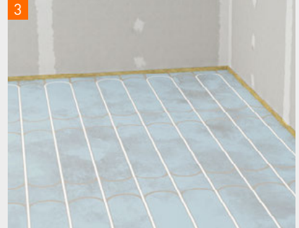
3 fermacell® Therm25™ elementen waarop gipslijm uitgegoten is.
