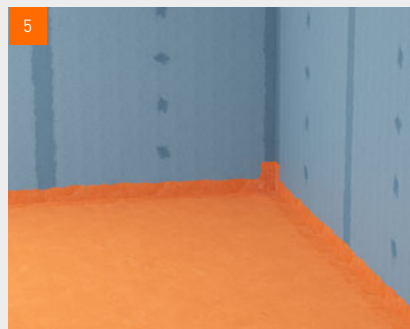
De vlakken in W1-l-zones volvlaks aanbrengen
